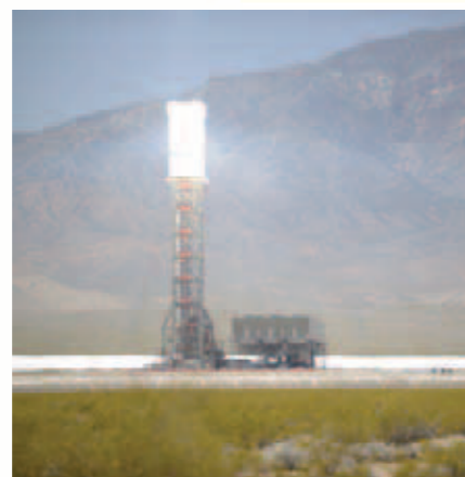
An der Spitze wird es mehr als 3000°C heiß: das Sonnenwärmekraftwerk Ivanpah, USA. Foto: © Aioannides, Wikipedia.de
